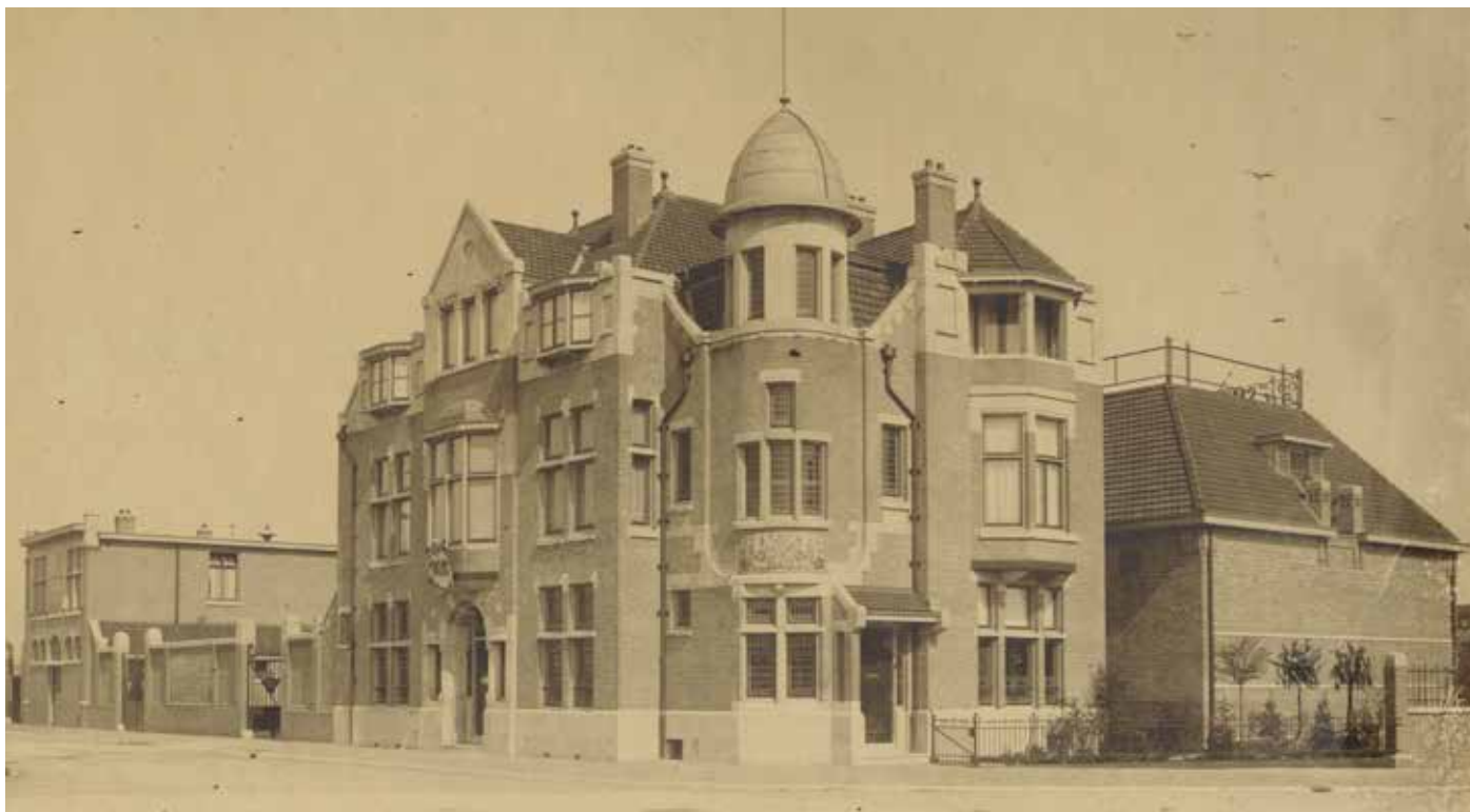
De Drie Hoefijzers in 1913 met v.l.n.r. de stalling, de kantoorvilla en het koelhuis. (foto Haags Gemeentearchief)
