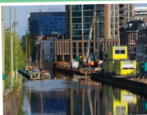
Aanbrengen tijdelijke damwand eerste deel kade Pletterijkade
