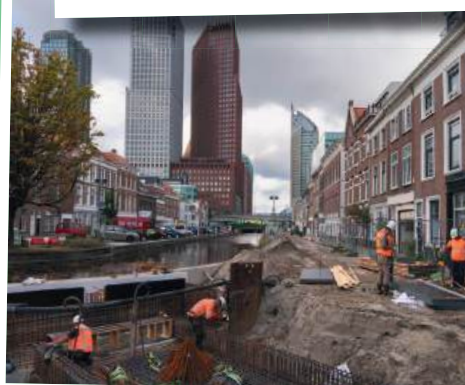
Aanbrengen wapeningsstaal voor nieuwe riool overstort Boomsluiterskade
