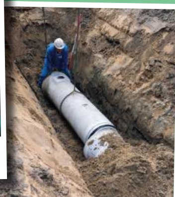
Vervangen riool Gouwestraat
