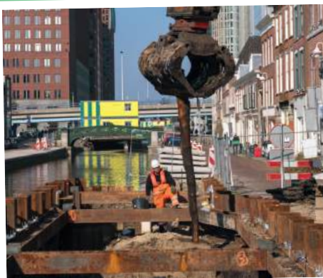
Verwijderen oude houten funderingspalen Boomsluiterskade
