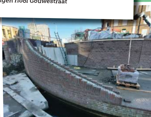
Metselwerk verlaagde werf Pletterijkade
