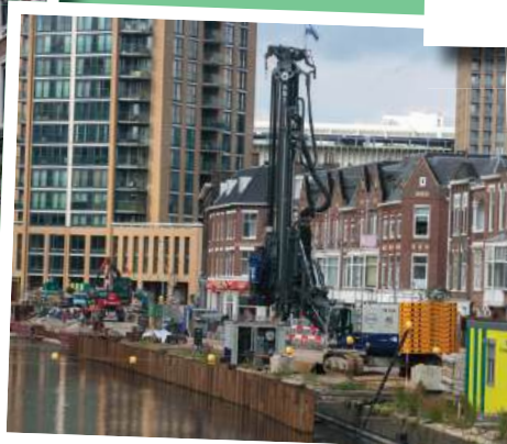
Aanbrengen tijdelijke damwand tweede deel kade Pletterijkade
